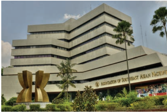
ที่ตั้งสำนักงานเลขาธิการอาเซียน ณ ประเทศอินโดนีเซีย ที่มา http://www.aseanhai.net/images/content/asean/1659asean_secretariat_building_by_halfenergized-d4da8lh.jpg
